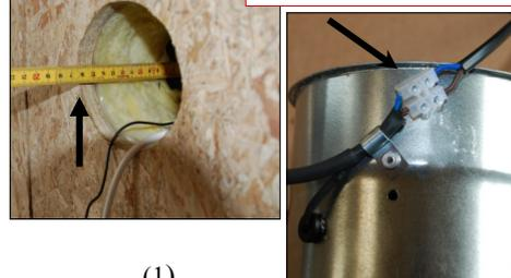
5. El ventilador con el filtro se inserta en el hueco y la corona del tubo de entrada (1) se atornilla al techo interior (la fotografía muestra el modelo M70). El filtro (3) se coloca con la parte punteaguda apuntando al ventilador. La válvula de inyección de aire se monta luego en la corona del tubo de entrada.
