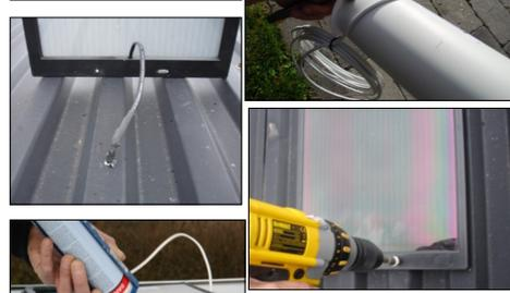
4. Desde dentro de la habitación, y con un metro se mide la distancia desde el tejado hasta el techo interior. El tubo de entrada puede acortarse de tal manera que con el montaje del ventilador haya entre 1 y 3 cm de distancia entre el ventilador del sistema de aspirado de aire y la parte de abajo del tejado (envés) que da a la parte interna de la casa. La misma distancia debe mantenerse en caso de instalación en pared.
