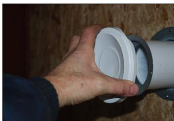
Se monta la válvula de inyección de aire
