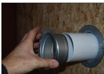
Acople a válvula de inyección de aire se monta en el tubo
