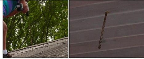
2. Con un perforador redondo o bien con una sierra fina se abre un hueco en el techo interior y en la capa de aislamiento. (110 mm para M40, 135 mm para M70 og 150 mm para M140) El cuello del tubo de entrada de aire del M40 puede eventualmente reducirse con un cuchillo stanly de manera que el hueco para el tubo sea más reducido.
