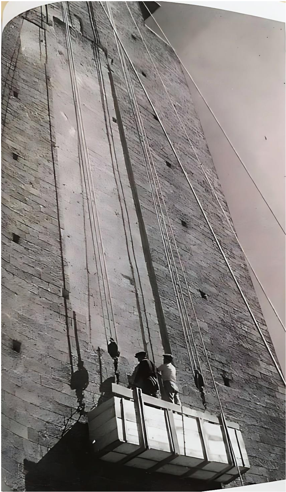
Rimozione dei fasci littori
