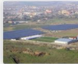
Nazna, Mures, RO 2,5 MW
