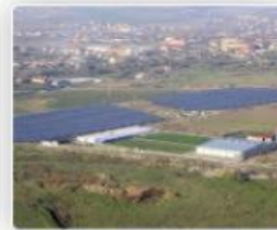
Nazna, Mures, RO 2,5 MW
