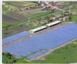
Ghindari, Mures, RO 2,5 MW
