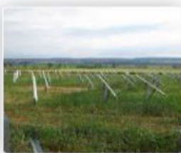
Oberempfenbach, Main... 2,2 MW
