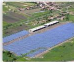
Ghindari, Mures, RO 2,5 MW
