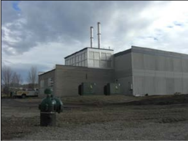
TierPoint 600 Ton Geothermal Data Center
