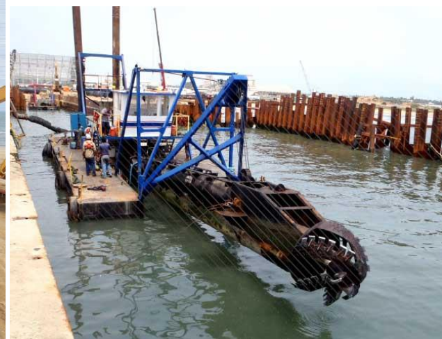
Canal Toma de Agua fría Planta Termo Zulia, 2006
