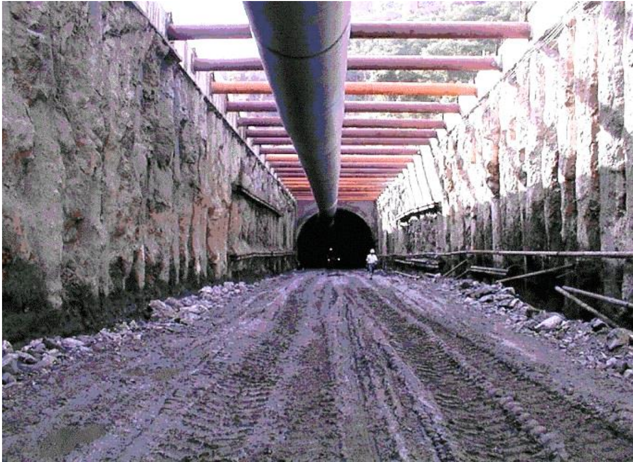
Portal Norte del túnel Tazón del Ferrocarril Caracas-Cúa: parte de la trinchera temporal con paredes verticales contenidas por muros de pilotes y de micropilotes
