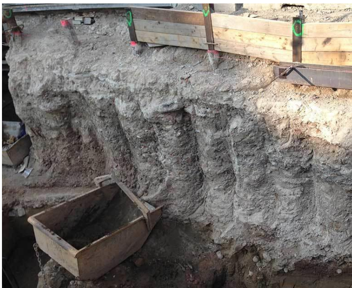
Estaciones Metro de Caracas: pozos de drenaje soportados temporalmente con muros de jet grouting
