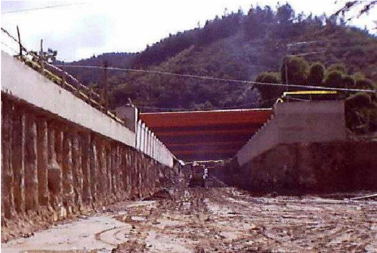
Al fondo la trinchera con las paredes verticales contenidas por muros de pilotes apuntalados
