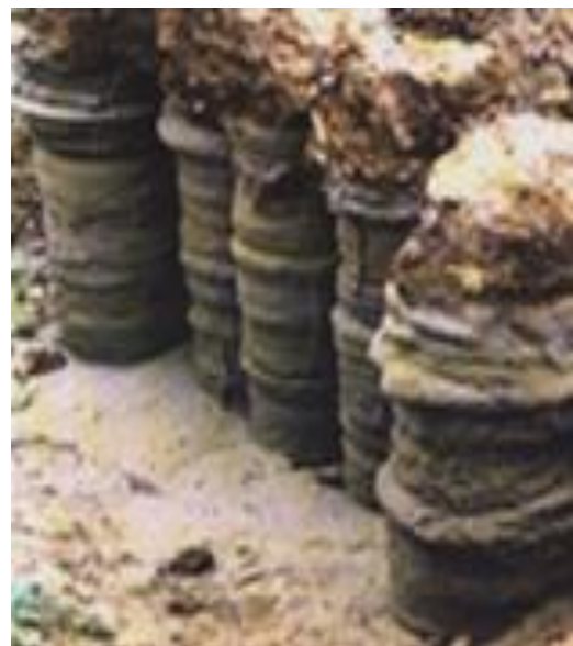
Estaciones Metro de Caracas: pozos de drenaje soportados temporalmente con muros de jet grouting
