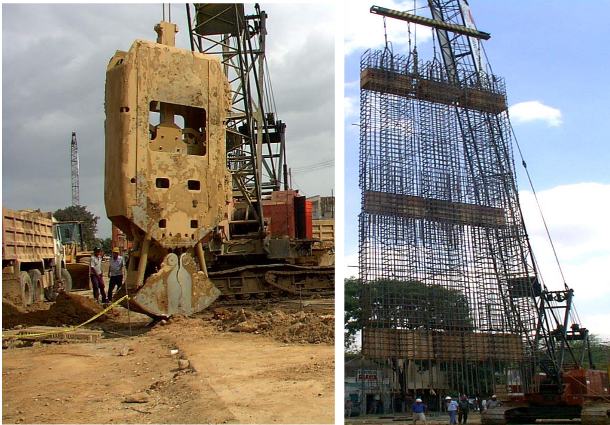
Excavación y armado de un panel de muro colado de la Estación Santa Rosa del Metro de Valencia nótese en la armadura los sitios de recesos que deben quedar en los muros para los empotramientos
