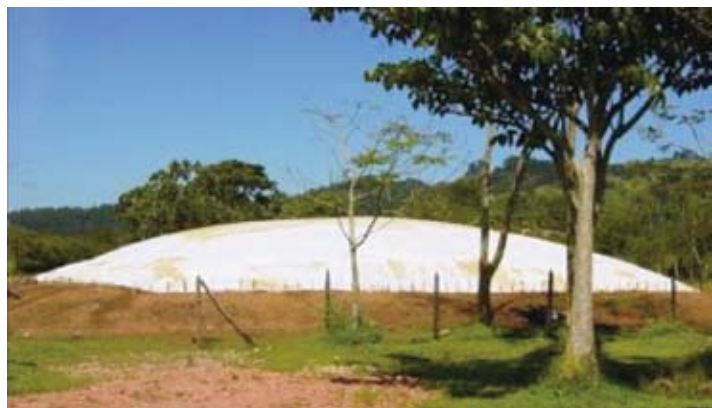
Imagen 2. Biodigestor tipo laguna tapada. Fotografía cortesía de la Ing. Irene Cañas;Tecnologías de Generación, ICE.
