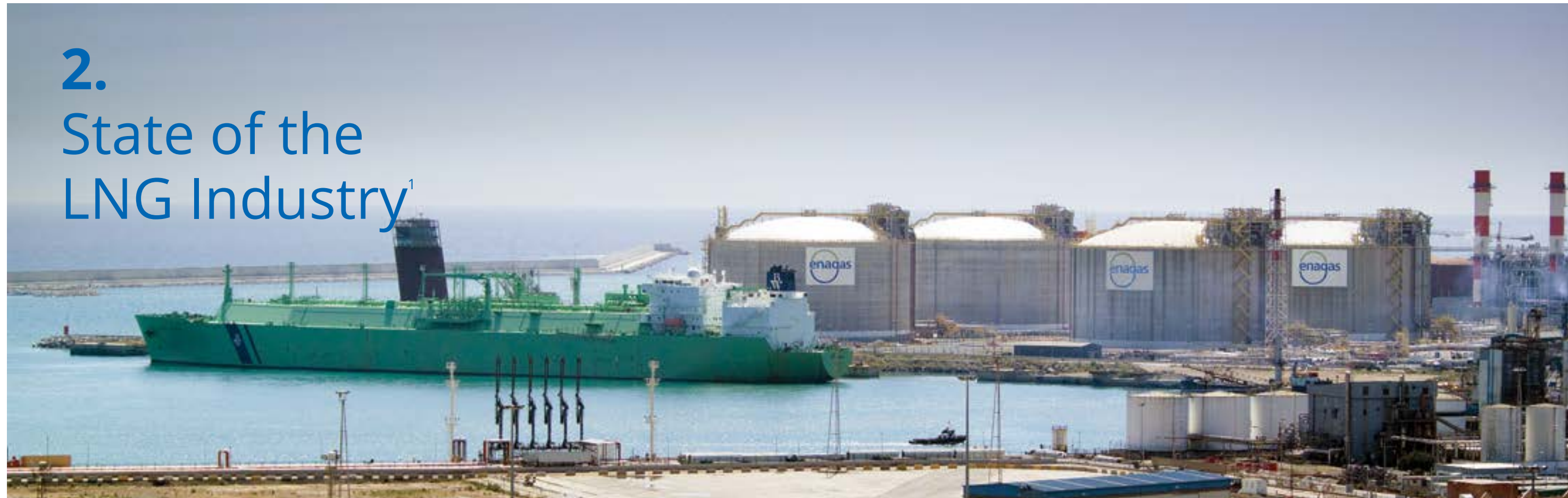
Barcelona LNG Terminal - Courtesy of Enagas
