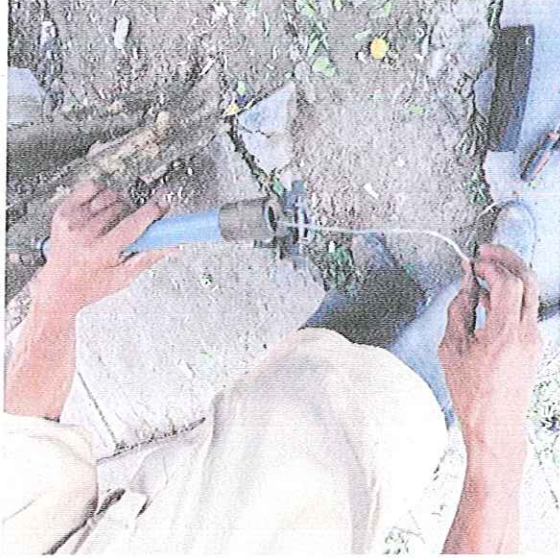
"SUMINISTRO Y COLOCACION DE BAJANTE DE TIERRAS EN REBOMBEO 23 DE MARZO, EN LA CIUDAD DE IGUALA GRO".
