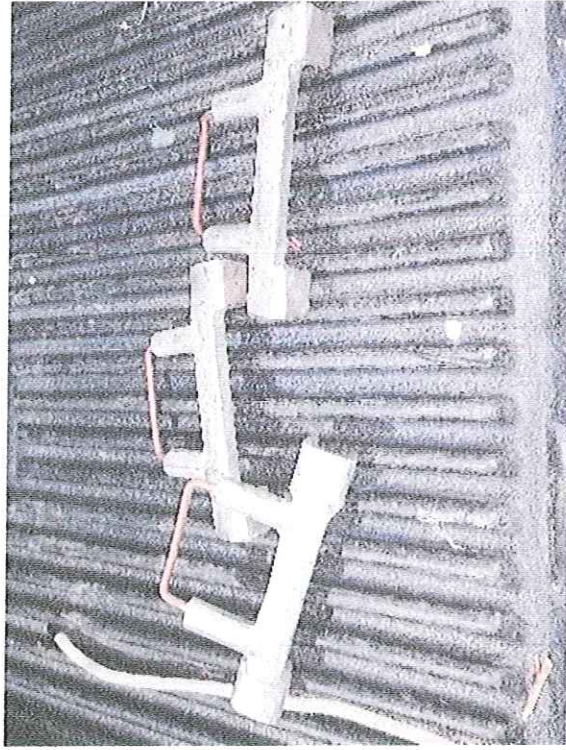
"SUMINISTRO Y COLOCACION DE BAJANTE DE TIERRAS EN REBOMBEO 23 DE MARZO, EN LA CIUDAD DE IGUALA GRO".
