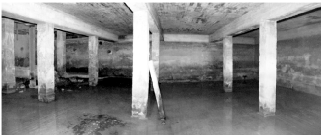
Usine de filtration utilisée jusqu'en 1958
