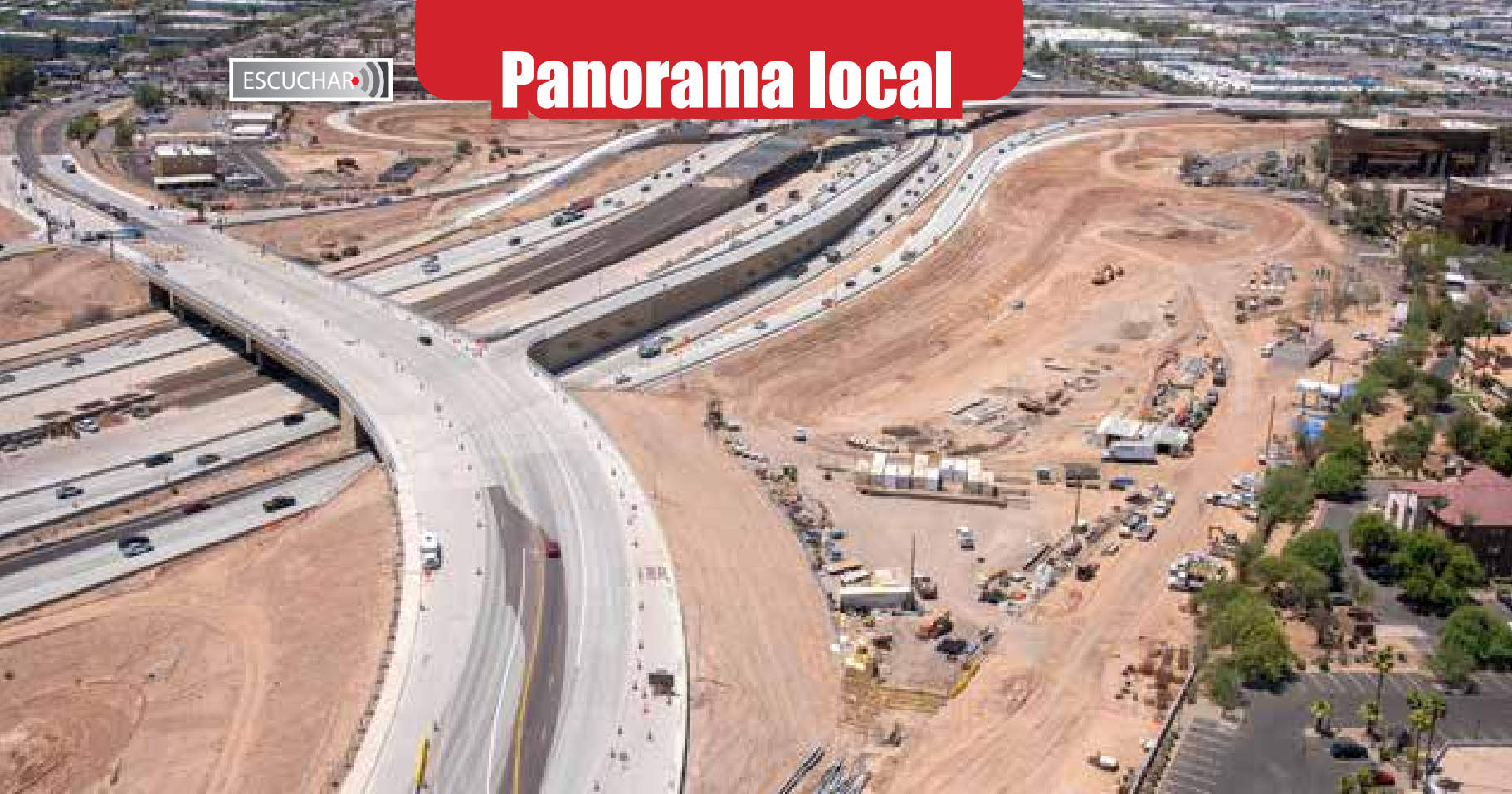
Carriles colectores-distribuidores en Baseline hacia el oeste. Fotografías: ADOT
