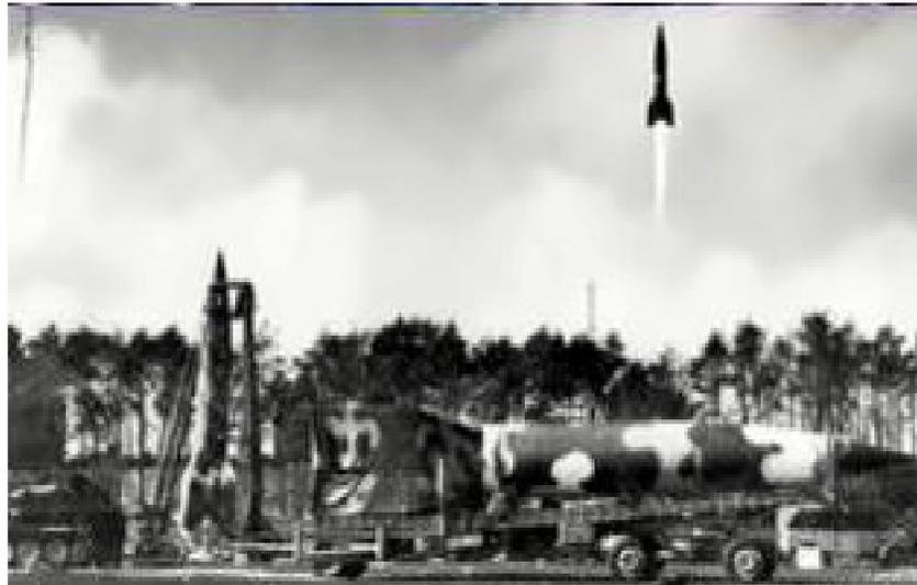
Die 14 m V-2-Rakete wird mit Alkohol und flüssigem Sauerstofftreibstoff auf eine Höhe von 90 km mit einer Geschwindigkeit von 5400 km/h mit einer Reichweite von 320 km und einer Traglast von 740 kg angetrieben. Alle modernen Raketen einschließlich der Mondrakete Saturn V basieren auf dem A4-Konzept.
