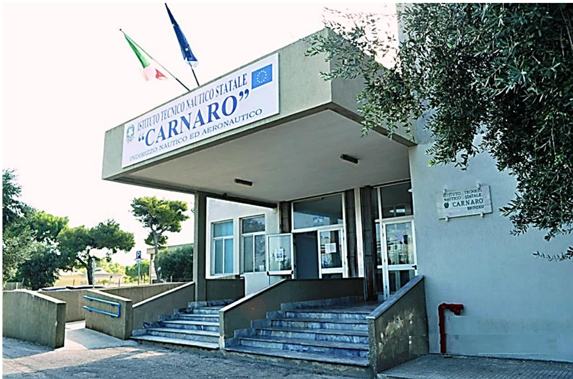
Sede attuale dell'Istituto Tecnico Statale Nautico Carnaro
