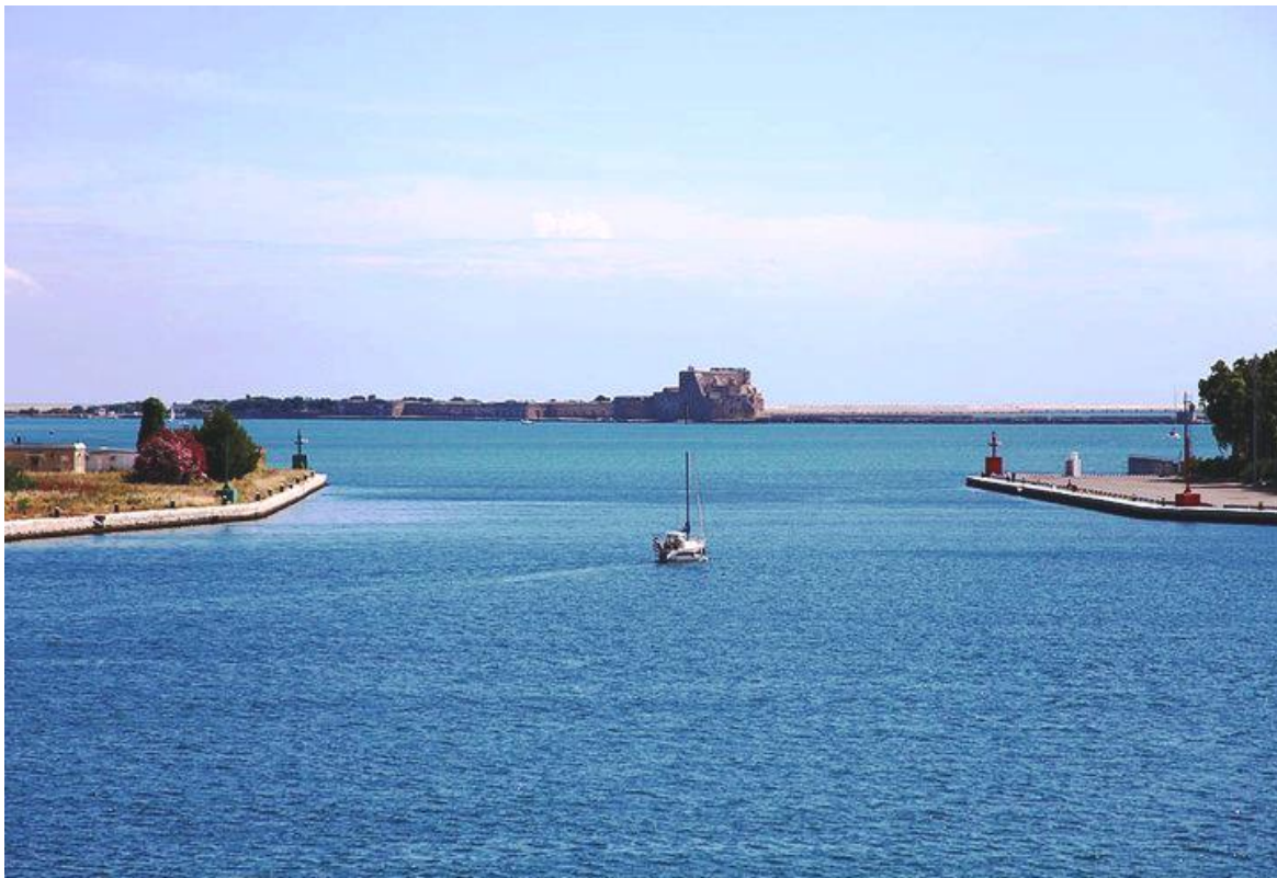
Il canale d'entrata al porto inteno
