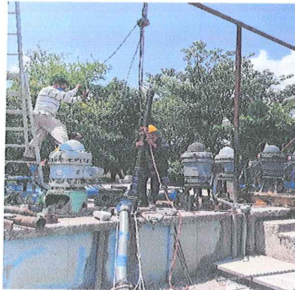
"SERVICIO DE REHABILITACION DE BOMBA, REBOMBEO TECNOLÓGICO, LOCALIZADO EN PERIFERICO NORTE DE LA CIUDAD DE IGUALA GRO".
