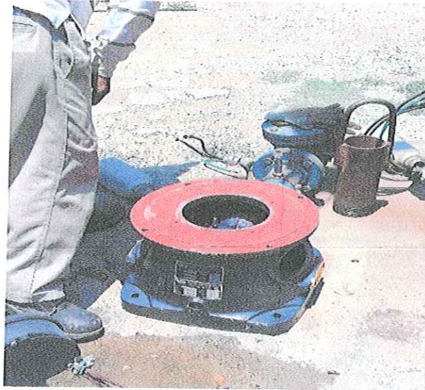
"SERVICIO DE REHABILITACION DE BOMBA, REBOMBEO TECNOLÓGICO, LOCALIZADO EN PERIFERICO NORTE DE LA CIUDAD DE IGUALA GRO".
