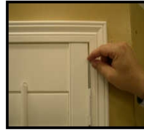
Insert hinge pin.
