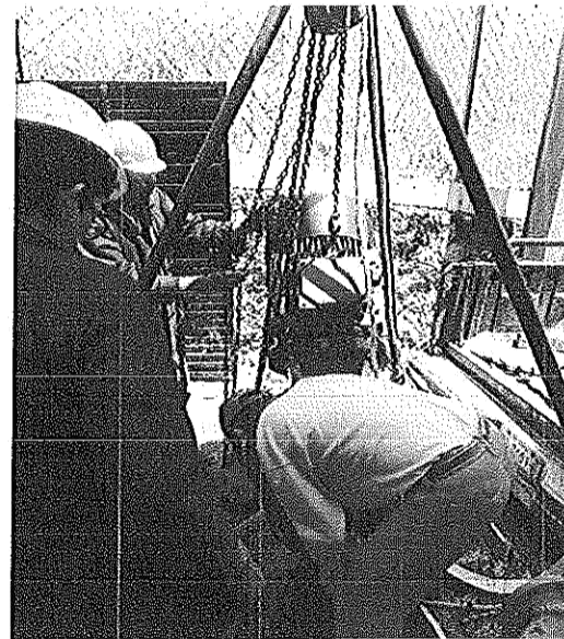
"SUMINISTRO, MONTAJE ELECTROMECANICO Y PRUEBAS DE UNA NUEVA BOMBA VERTICAL MULTIPASOS 40 HP/440V, EN REBOMBEO ACUAFERICO HEBERTO-MIRADOR, LOCALIZADO EN LA COL. HEBERTO CASTILLO, DE IGUALA GRO".
