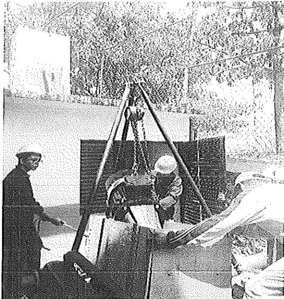
"SUMINISTRO, MONTAJE ELECTROMECANICO Y PRUEBAS DE UNA NUEVA BOMBA VERTICAL MULTIPASOS 40 HP/440V, EN REBOMBEO ACUAFERICO HEBERTO-MIRADOR, LOCALIZADO EN LA COL. HEBERTO CASTILLO, DE IGUALA GRO".
