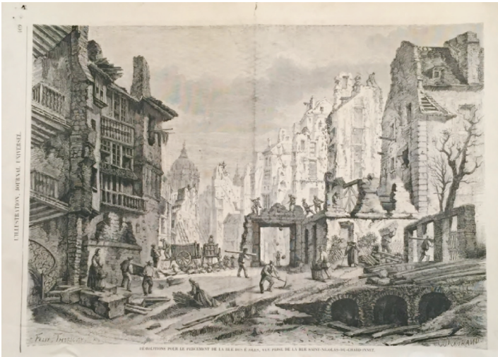
Fig. 2. Charles Murand (engraver), Démolitions pour le percement de la rue des Écoles, vue prise de la rue Saint-Nicolas-du-Chardonnet [Demolitions for the building of Rue des Ecoles, view taken from rue Saint-Nicolas-du-Chardonnet]. From L'illustration, Journal Universel , June 26, 1858. Collection of the author.
