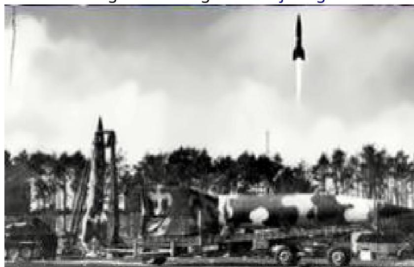
Raketa V-2 od 14 m se pogoni alkoholom i tekućim kisikovim gorivom do visine od 90 km pri brzini od 5400 km/h s dometom od 320 km i teretom od 740 kg.Sve moderne rakete uključujući raketu za Mjesec Saturn V temelje se na konceptu A4.
