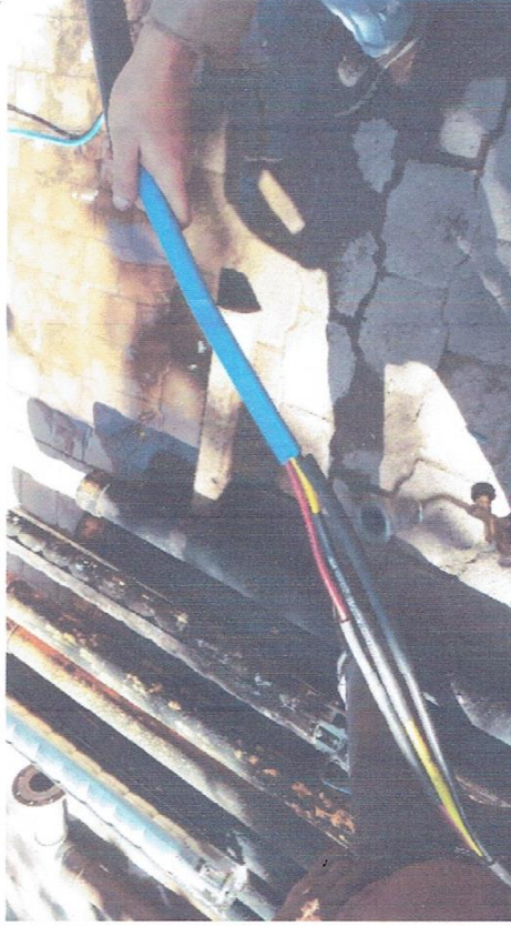
"SUMINISTRO, MONTAJE ELECTROMECANICO Y PRUEBAS DE UNA BOMBA SUMERGIBLE 40 HP/440V-90 MT DE COLUMNA ACERO AL CARBON, EN BOMBEO POZO PROFUNDO 5, LOCALIZADO EN EL ZOCALO DE IGUALA GRO".
