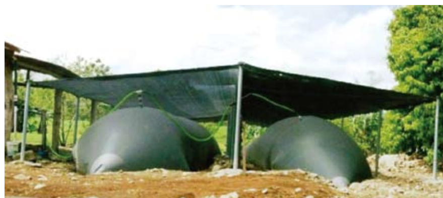
Figura 3. Biodigestores tubulares de PVC
