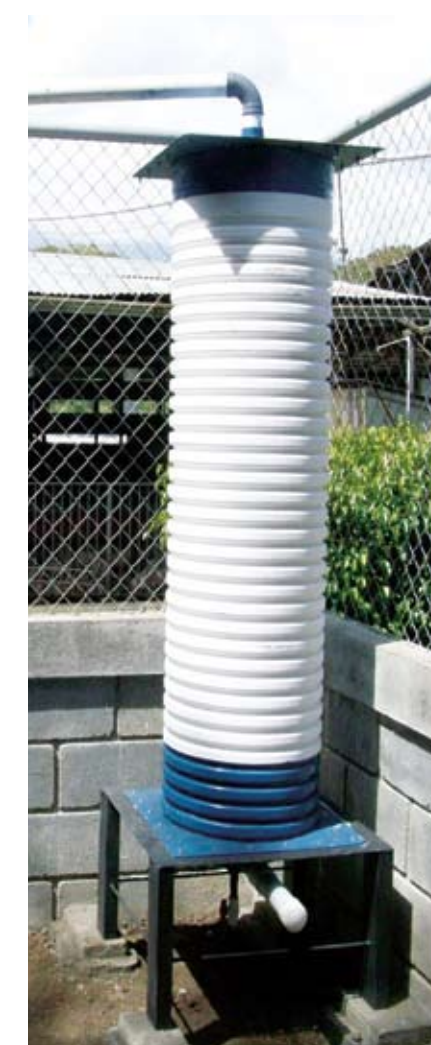
Figura 4. Filtro para la remoción de H_2S en el biogás. Marca VIOGAZ®.
