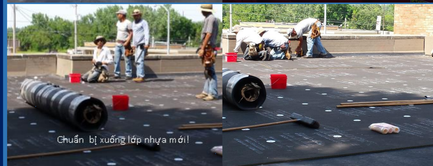
Mái nhà đang được chuẩn bị để lên thêm 1 lớp chống lạnh (insulation) trước khi trải tấm nhựa mới lên
