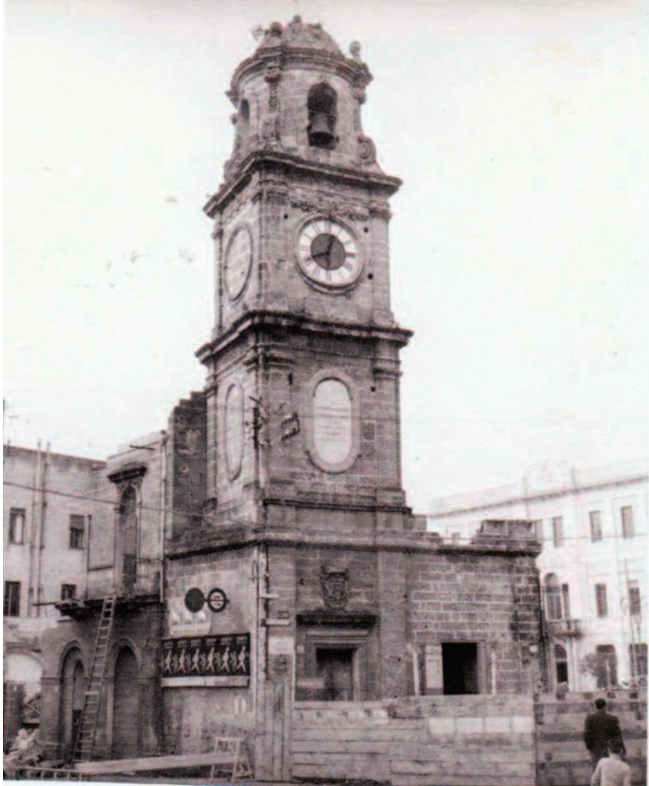
LE IMMAGINI La demolizione della Torre dell'Orologio nel centro di Brindisi, in basso un'immagine della Torre nel primo Novecento. Nella pagina accanto l'inizio della demolizione del teatro Verdi
