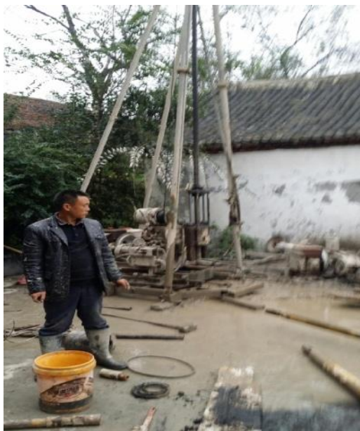
工人在施工现场
