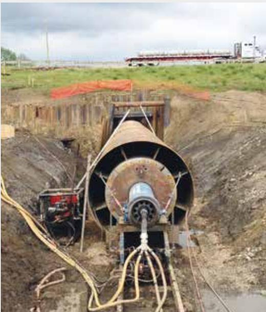
Los martillos neumáticos GRUNDORAM destruyen obstáculos y superan con facilidad el arranque después de tiempos de parada. La precisión se obtiene porque el impacto dinámico perfora el suelo sin desplazar todos los obstáculos, que debe ir empujando ante sí. La tierra se recoge en la tubería de acero delantera y, generalmente, se expulsa por medio de aire comprimido o agua.
