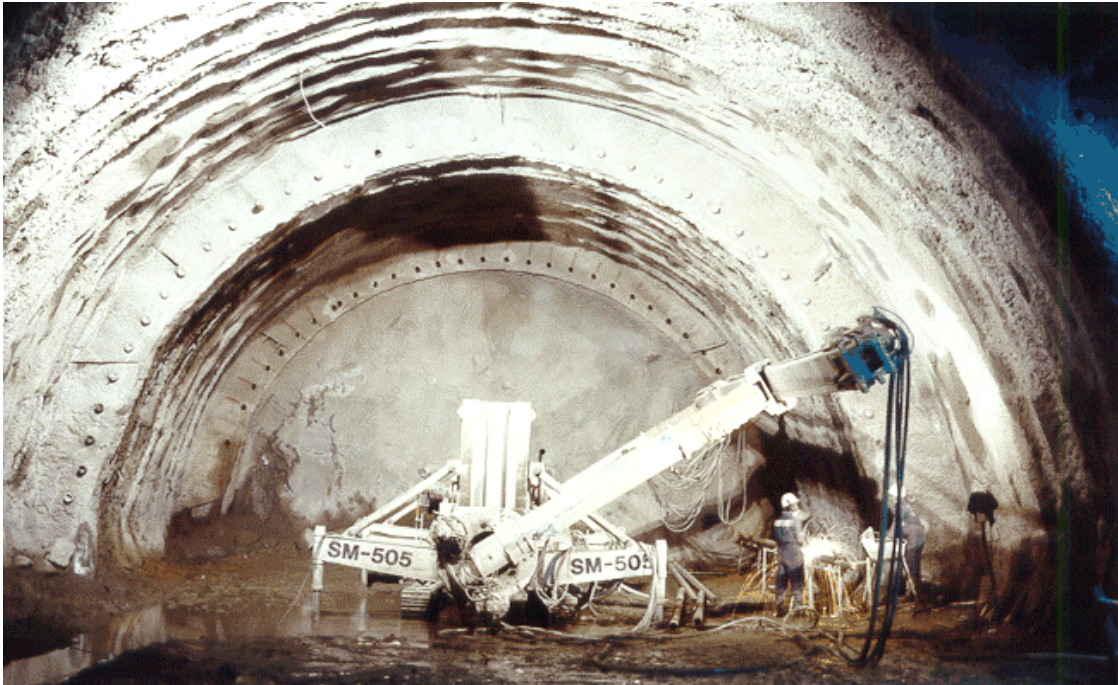
Ferrocarril Caracas-Cúa – Perforación del arco de micropilotes y elementos de vidrioresina
