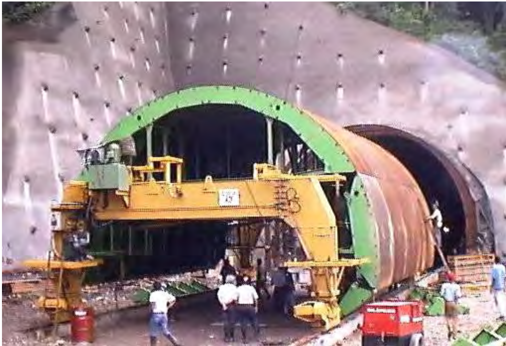
Ferrocarril Caracas-Cúa – Encofrado deslizante para el vaciado del revestimiento
