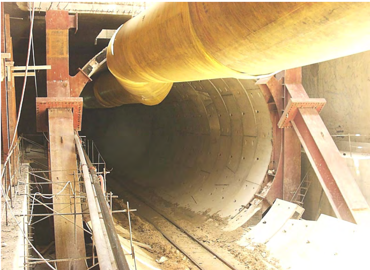
Metro de Valencia – Túnel revestido con anillos prefabricados universales
