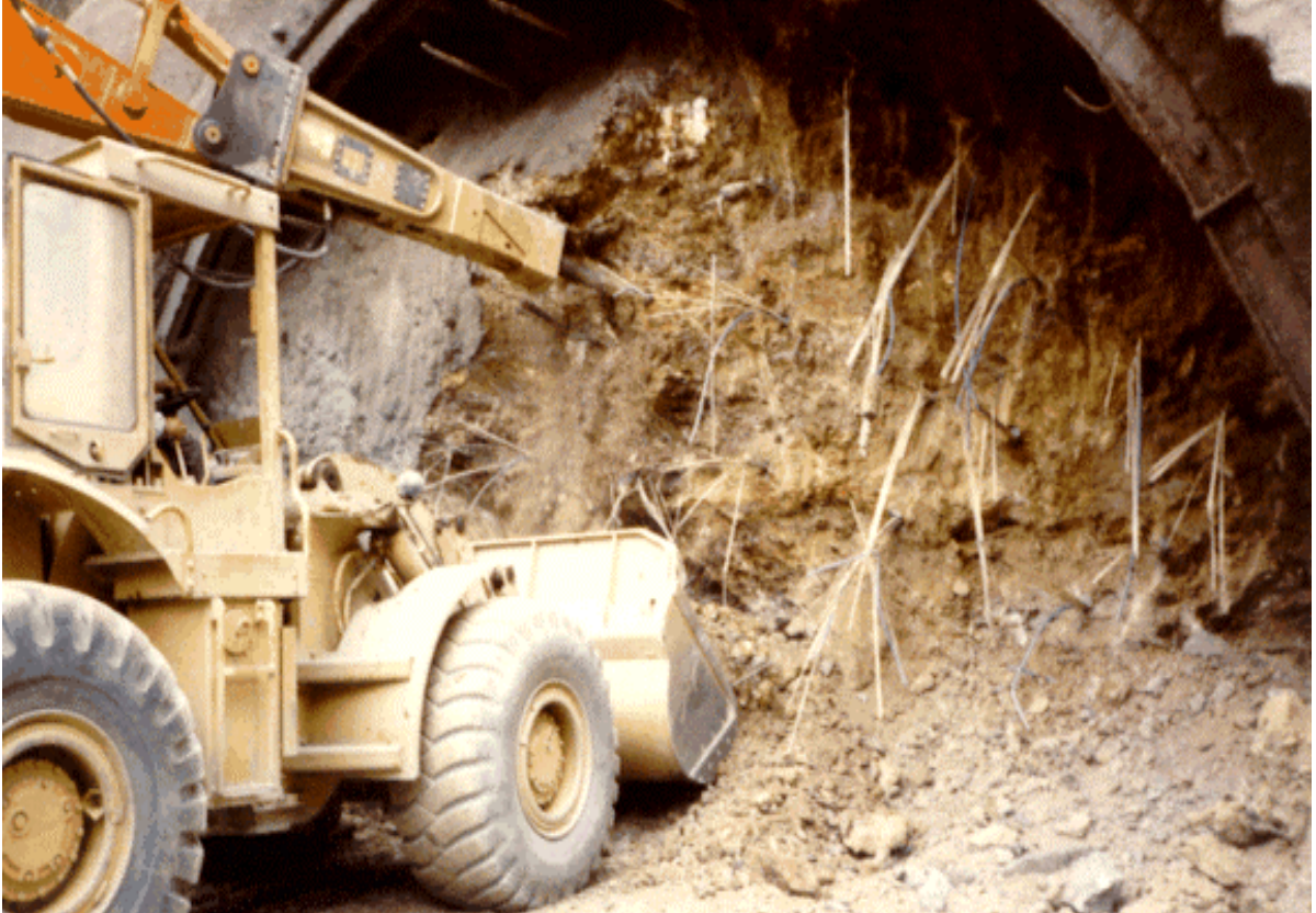
Ferrocarril Caracas-Cúa –Excavación con demolidor de un frente reforzado con vidrio-resinas
