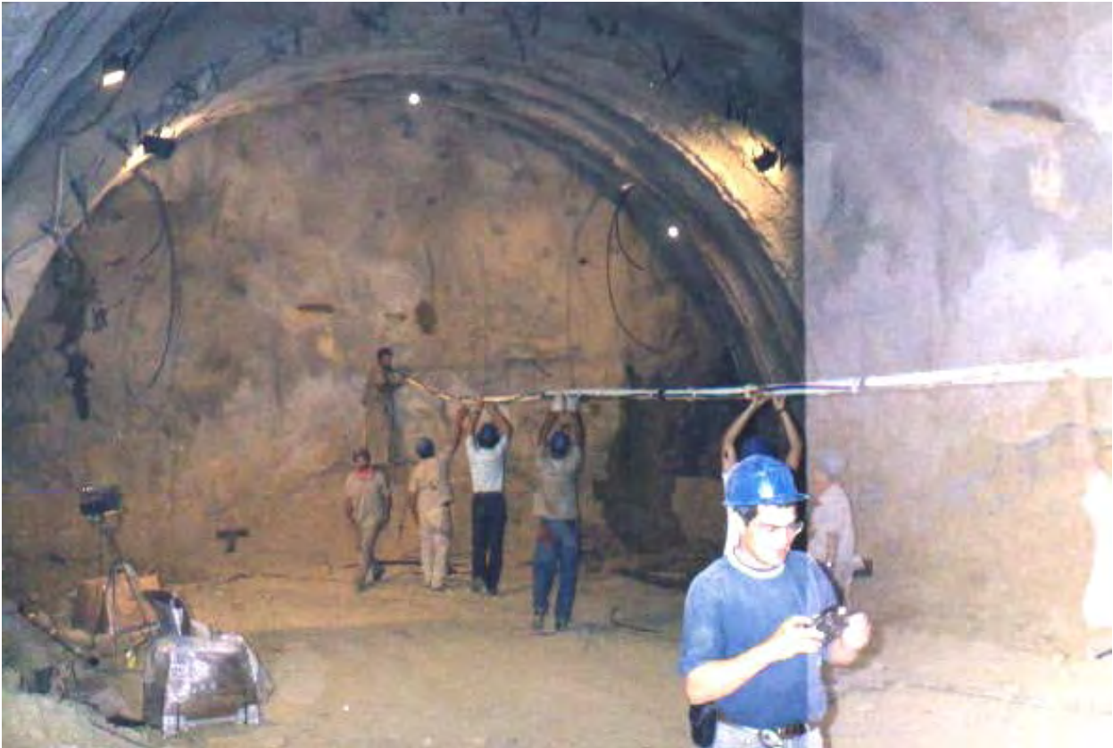
Ferrocarril Caracas-Cúa – Instrumentación del frente con extensómetro incremental
