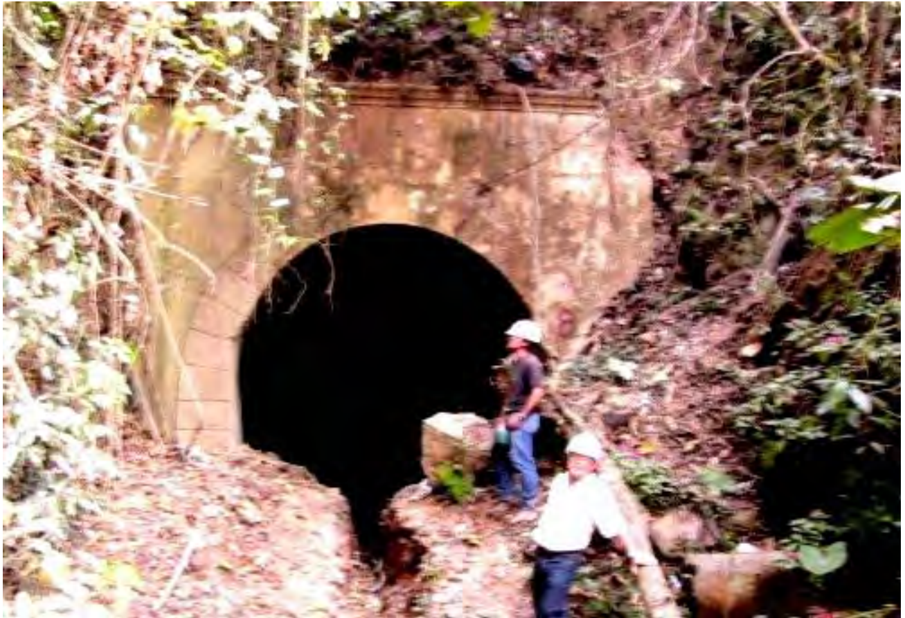
Ferrocarril Caracas-Los Teques: Un Túnel del “Tren del encanto”
