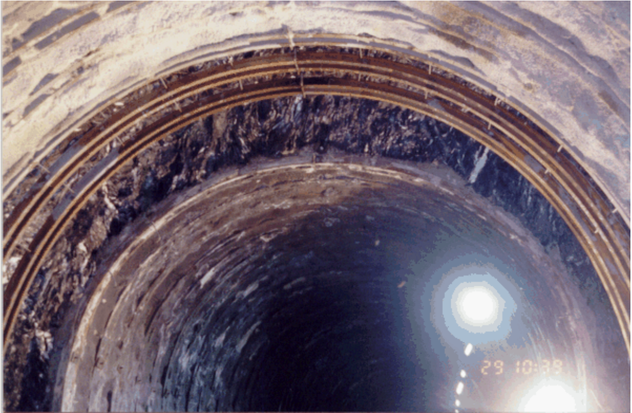
Ferrocarril Caracas-Cúa –Re-perfilado para convergencias atípicas de squeezing
