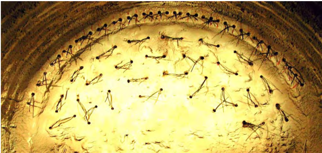
Ferrocarril Caracas-Cúa – Perforación del arco de micropilotes y elementos de vidrioresina
