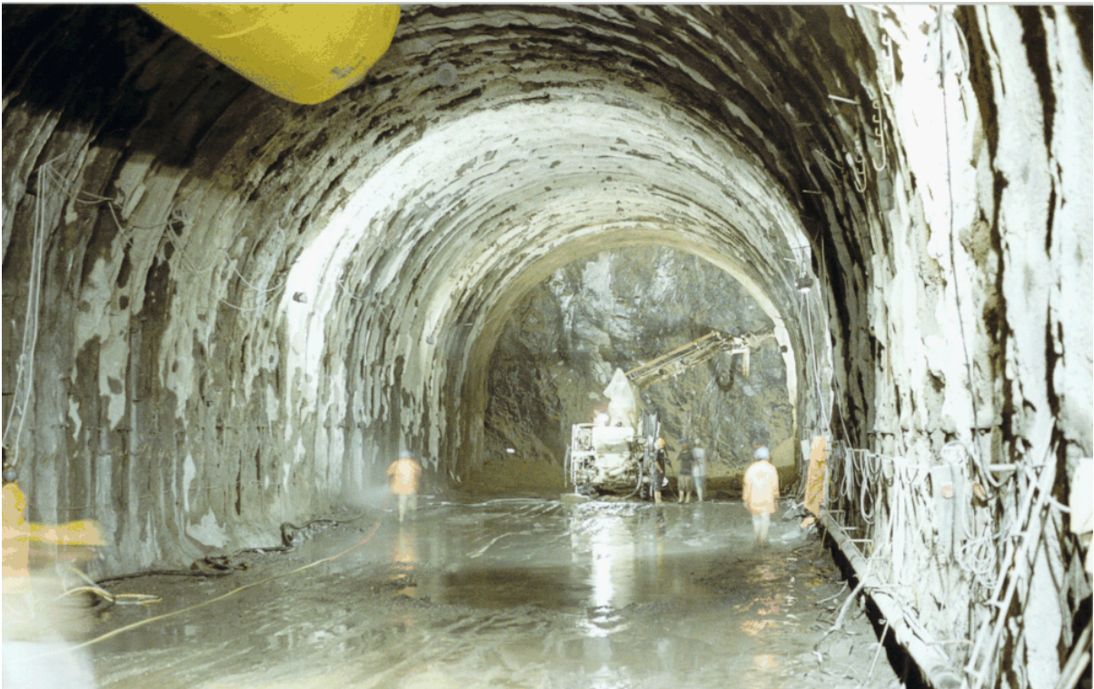
Ferrocarril Caracas-Cúa – Excavación con avance a sección completa
