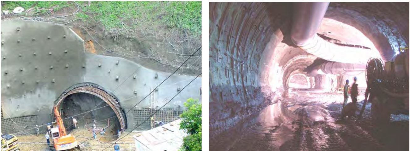
Metro de Los Teques – Portales externo e interno y de la Ventana vehicular Carrizalito
