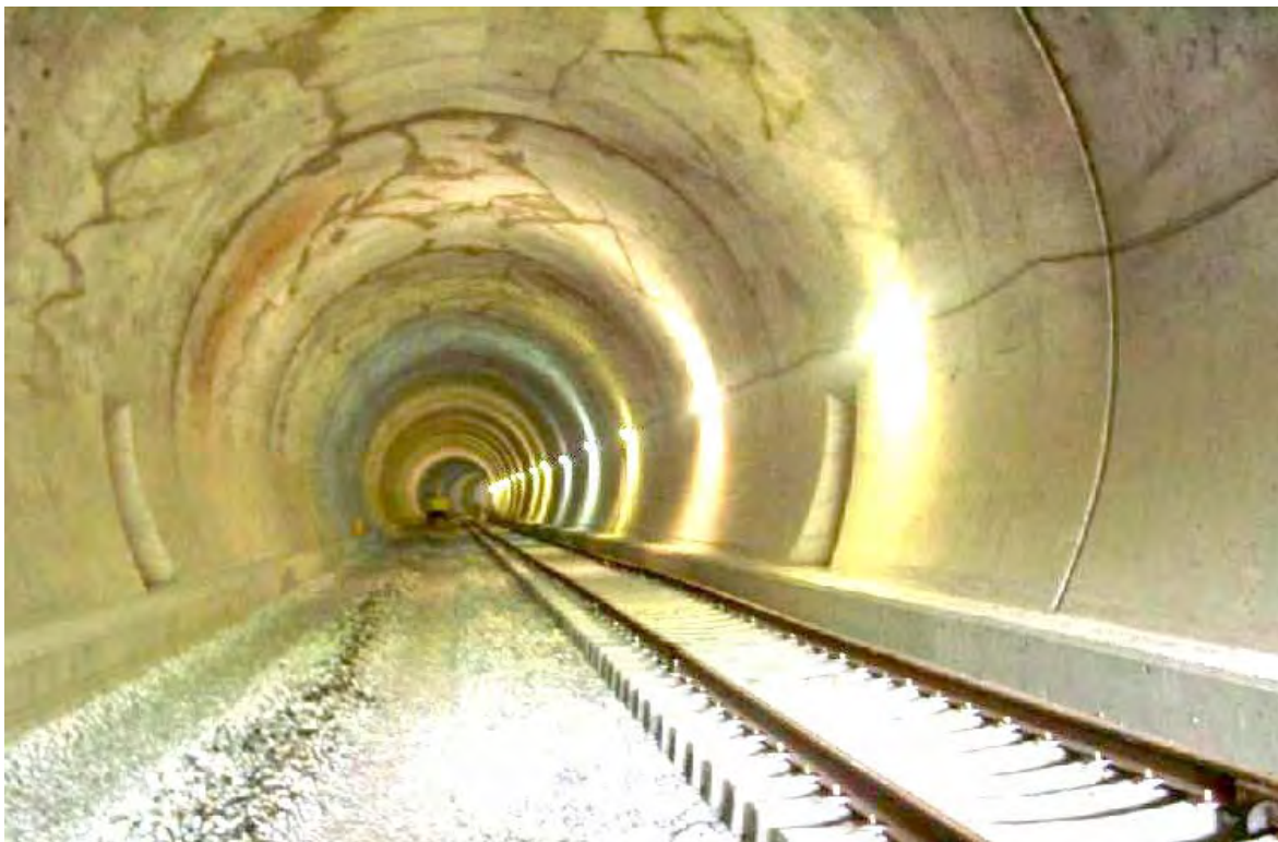
Ferrocarril Caracas-Cúa – Sección final de los túneles
