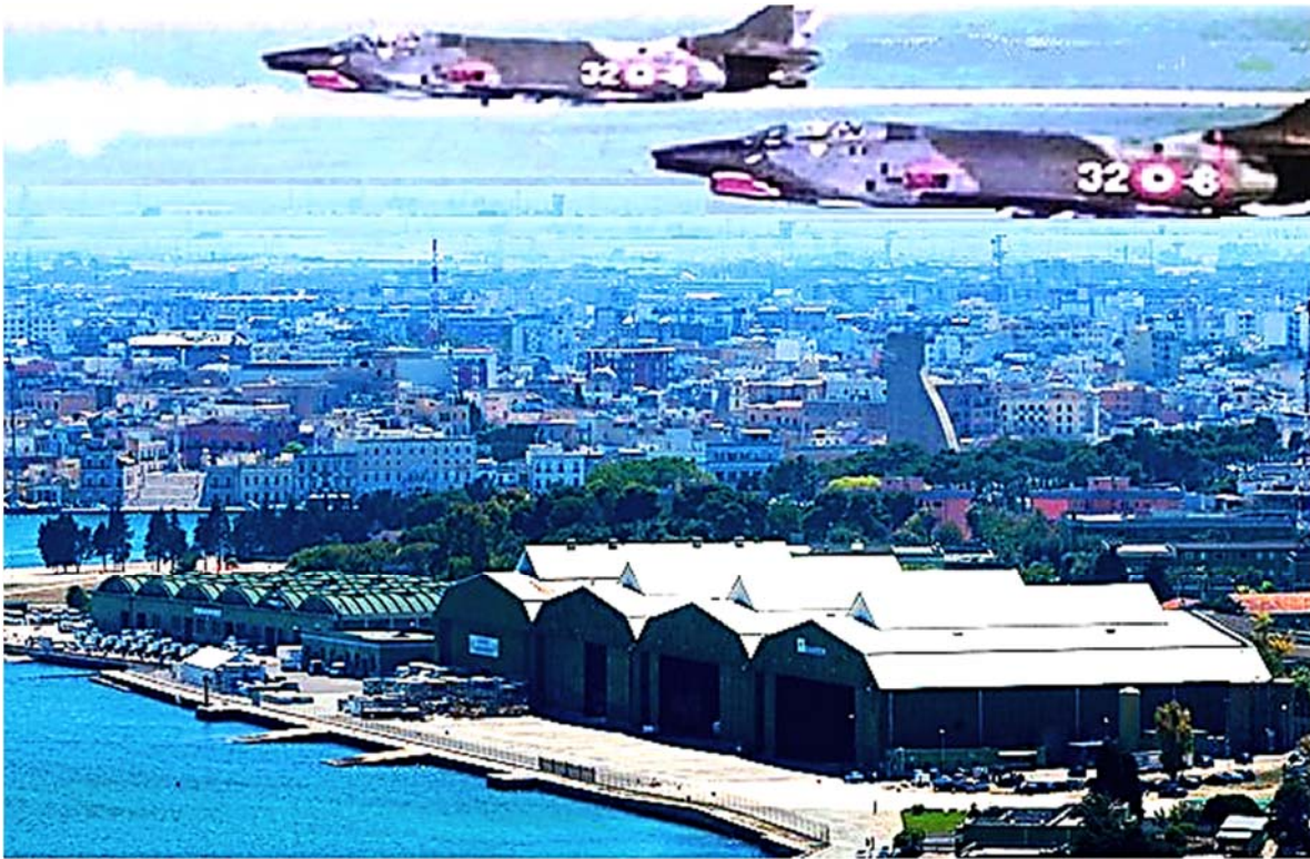
Gli Hangars che furono dell'Idroscalo di Brindisi: i 4 Savigliano e i 6 Bresciani
