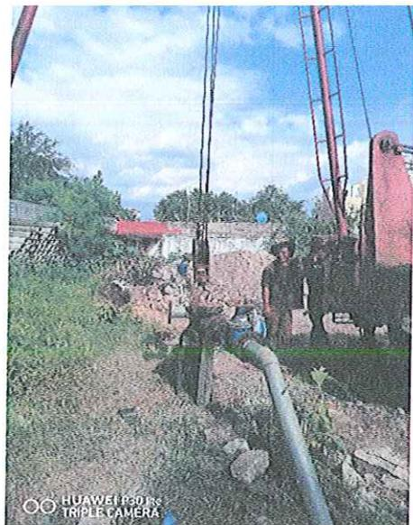
MONTAJE ELECTROMECANICO DE UNA BOMBA SUMERGIBLE 40 HP/440V- 84 MT DE COLUMNA ACERO AL CARBON 4", EN BOMBEO POZO PROFUNDO 8, LOCALIZADO EN LA COL. ALVAREZ DE ESTA CD. IGUALA GRO
