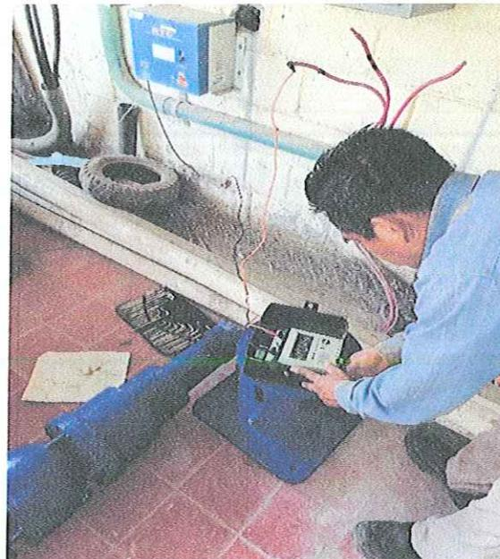
MONTAJE ELECTROMECANICO DE UNA BOMBA SUMERGIBLE 40 HP/440V- 84 MT DE COLUMNA ACERO AL CARBON EN BOMBEO POZO PROFUNDO 8, LOCALIZADO EN LA COL. ALVAREZ DE ESTA CD. IGUALA GRO
