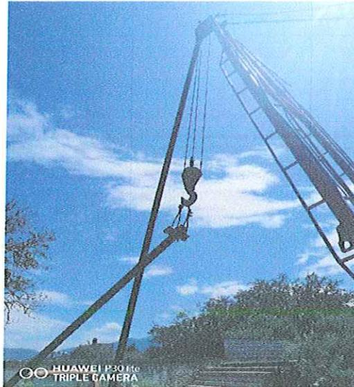
**MONTAJE ELECTROMECANICO DE UNA BOMBA SUMERGIBLE 40 HP/440V- 84 MT DE COLUMNA ACERO AL CARBON 4", EN BOMBEO POZO PROFUNDO 8, LOCALIZADO EN LA COL. ALVAREZ DE ESTA CD. IGUALA GRO**
