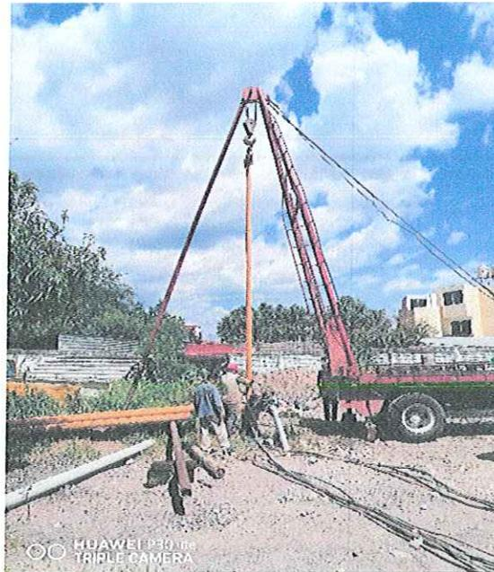
**MONTAJE ELECTROMECANICO DE UNA BOMBA SUMERGIBLE 40 HP/440V- 84 MT DE COLUMNA ACERO AL CARBON 4", EN BOMBEO POZO PROFUNDO 8, LOCALIZADO EN LA COL. ALVAREZ DE ESTA CD. IGUALA GRO**
