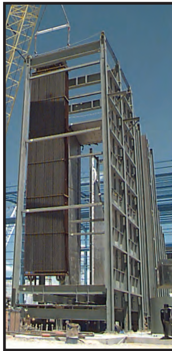
HRSG Casing & Module Installation
