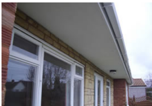
Asbestos Soffit
