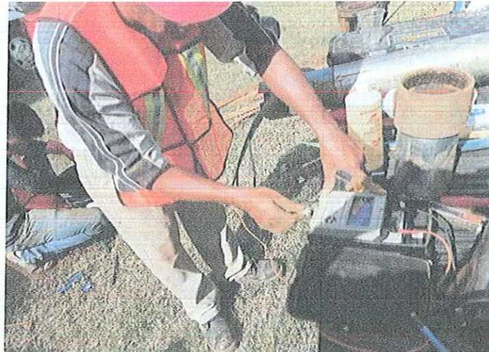
MONTAJE ELECTROMECANICO DE UNA BOMBA SUMERGIBLE 30 HP/220V- 54 MT DE COLUMNA ACERO AL CARBON 4",REPARADA PROPIEDAD DE CAPAMI,EN BOMBEO POZO PROFUNDO SAN GERARDO , LOCALIZADO EN CALLE GARCIA DE LA CADENA , ESQUINA CALLE DEL HUERTO, DE ESTA CIUDAD DE IGUALA GRO.
