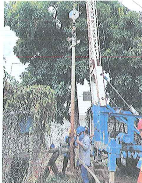
MONTAJE ELECTROMECANICO DE UNA BOMBA SUMERGIBLE 30 HP/220V- 54 MT DE COLUMNA ACERO AL CARBON 4",REPARADA PROPIEDAD DE CAPAMI,EN BOMBEO POZO PROFUNDO SAN GERARDO , LOCALIZADO EN CALLE GARCIA DE LA CADENA , ESQUINA CALLE DEL HUERTO, DE ESTA CIUDAD DE IGUALA GRO.
