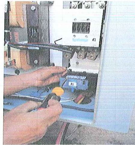
MONTAJE ELECTROMECANICO DE UNA BOMBA SUMERGIBLE 30 HP/220V- 54 MT DE COLUMNA ACERO AL CARBON 4",REPARADA PROPIEDAD DE CAPAMI,EN BOMBEO POZO PROFUNDO SAN GERARDO , LOCALIZADO EN CALLE GARCIA DE LA CADENA , ESQUINA CALLE DEL HUERTO, DE ESTA CIUDAD DE IGUALA GRO.
