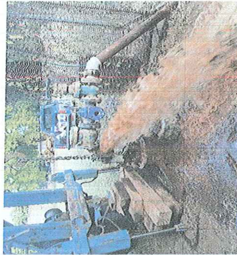
MONTAJE ELECTROMECANICO DE UNA BOMBA SUMERGIBLE 30 HP/220V- 54 MT DE COLUMNA ACERO AL CARBON 4",REPARADA PROPIEDAD DE CAPAMI,EN BOMBEO POZO PROFUNDO SAN GERARDO , LOCALIZADO EN CALLE GARCIA DE LA CADENA , ESQUINA CALLE DEL HUERTO, DE ESTA CIUDAD DE IGUALA GRO.
