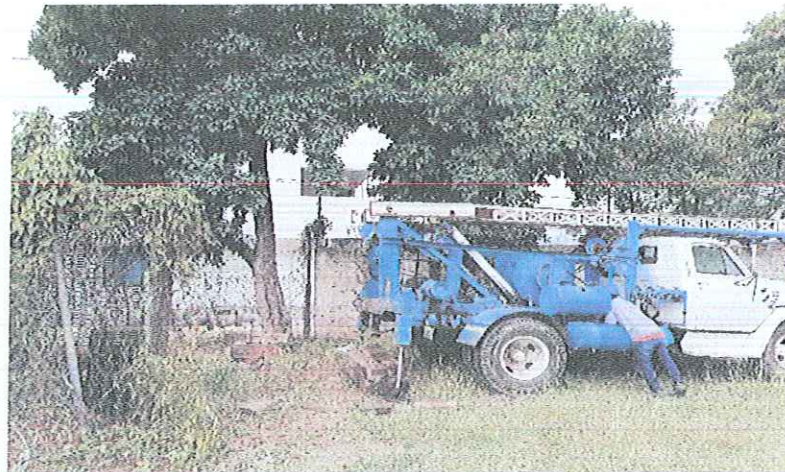
MONTAJE ELECTROMECANICO DE UNA BOMBA SUMERGIBLE 30 HP/220V- 54 MT DE COLUMNA ACERO AL CARBON 4",REPARADA PROPIEDAD DE CAPAMI,EN BOMBEO POZO PROFUNDO SAN GERARDO , LOCALIZADO EN CALLE GARCIA DE LA CADENA , ESQUINA CALLE DEL HUERTO, DE ESTA CIUDAD DE IGUALA GRO.
