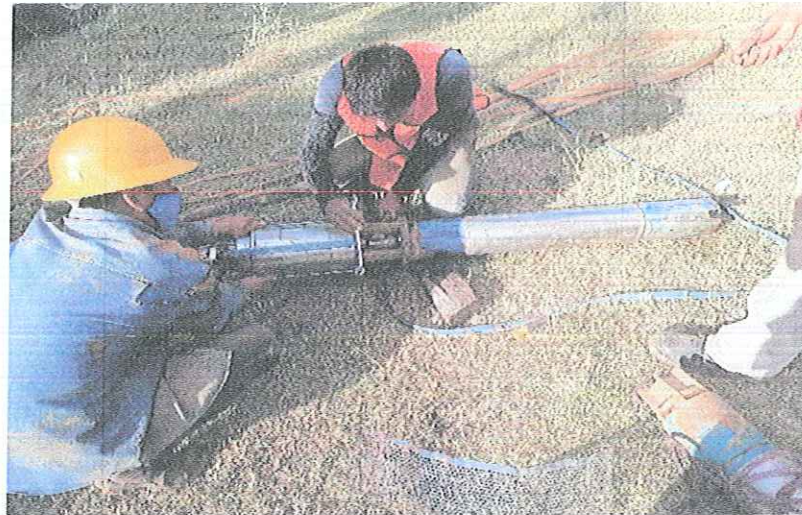
MONTAJE ELECTROMECANICO DE UNA BOMBA SUMERGIBLE 30 HP/220V- 54 MT DE COLUMNA ACERO AL CARBON 4", REPARADA PROPIEDAD DE CAPAMI, EN BOMBEO POZO PROFUNDO SAN GERARDO, LOCALIZADO EN CALLE GARCIA DE LA CADENA, ESQUINA CALLE DEL HUERTO, DE ESTA CIUDAD DE IGUALA GRO.
