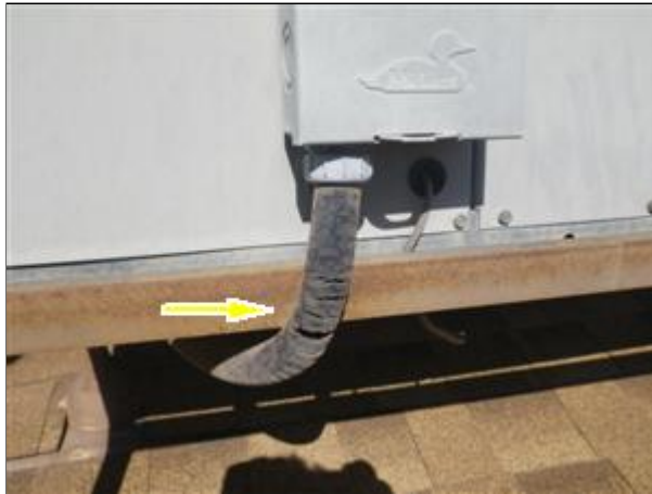
damaged conduit
