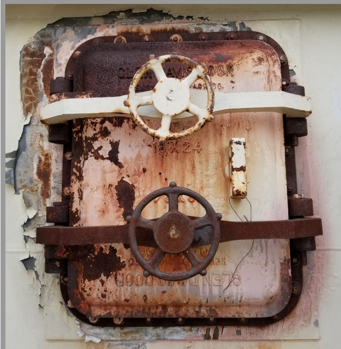
Old HRSG Access Door
