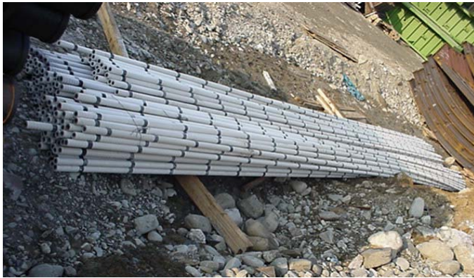
Elementos VTR tubulares con camisa interna plástica y válvulas de inyección
