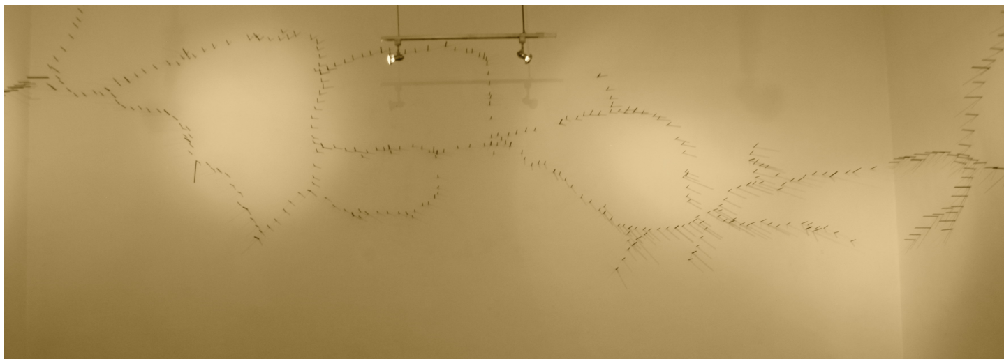
Lineas de Interferencia, muro norte
