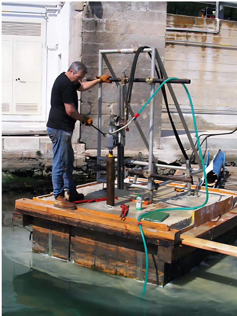
Carotaggio della pila sperimentale a Brindisi dal 2005 al 2009
