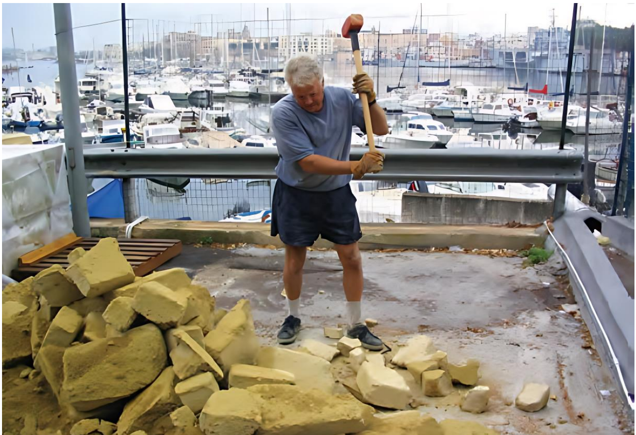
Blocchi di tufo ridotti manualmente in pietre per l'arido del calcestruzzo – Brindisi, settembre 2004
