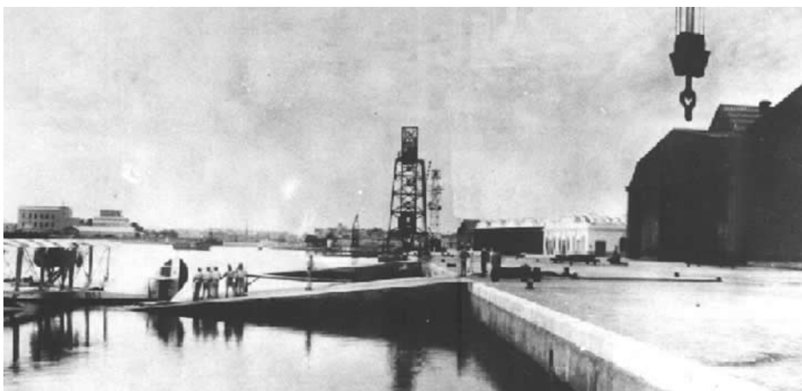
Rampe di scivoli all'Idroscalo di Brindisi - 1934
