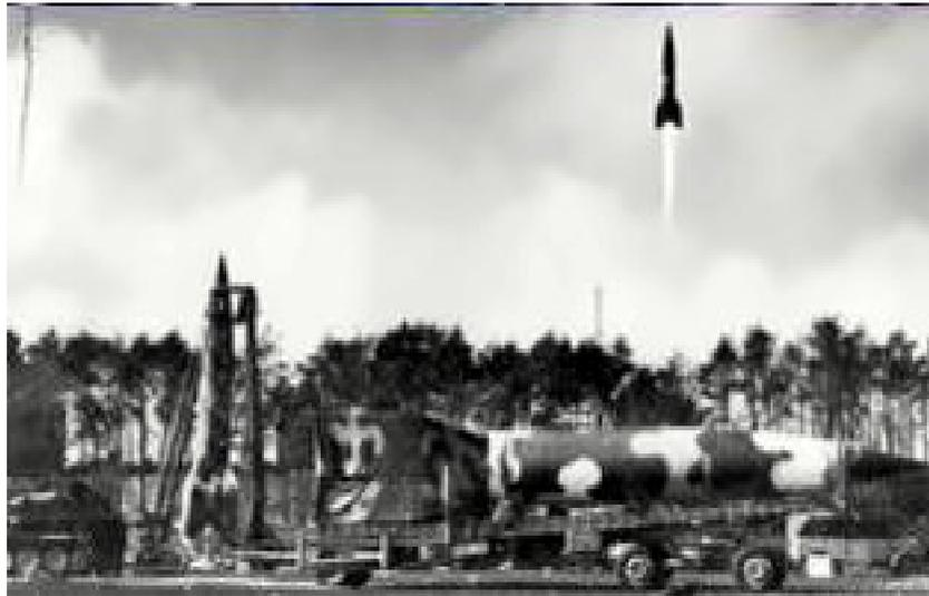
U razzi V-2 di 14 m hè propulsatu da l'alcool u carburante di l'ossigen u liquidu à una altitudine di 90 km à una vitezza di 5400 km / h cù una gamma di 320 km è una carica di 740 kg.Tutti i razzi muderni, cumpresu a raquette lunare Saturn V, sò basati nantu à u cuncettu A4.
