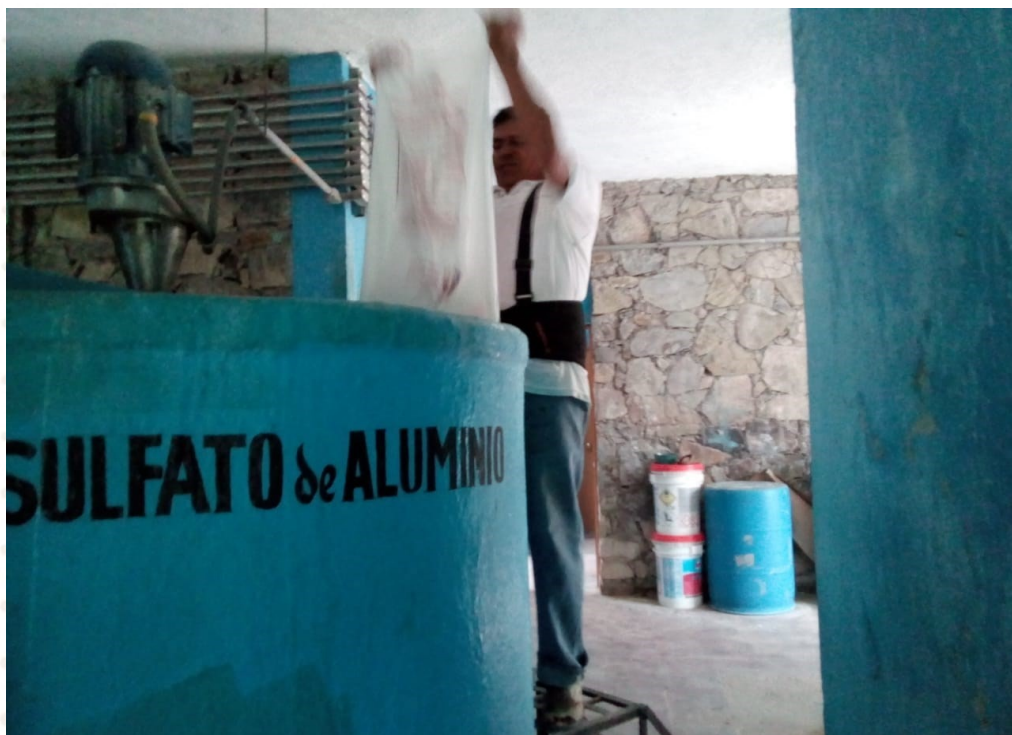
APLICACIÓN SE SULFATO DE ALUMINIO
