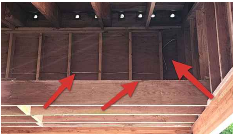
Place in conduit
