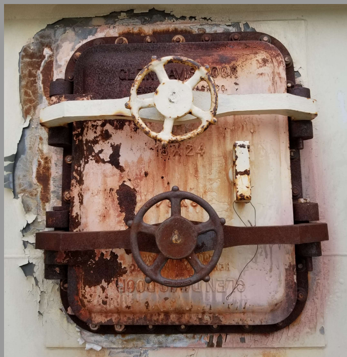
Old HRSG Access Door
