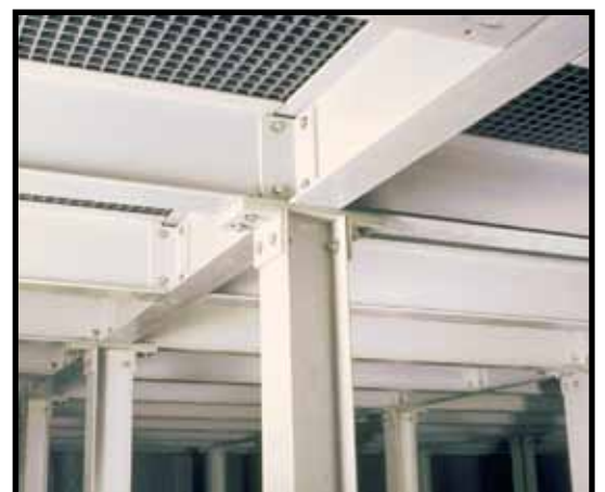
El diseño y la ingeniería avanzados de los perfiles estructurales Dynaform brindan una estructura de soporte liviana y de alta resistencia para esta instalación de chapado.
