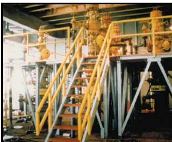
La estructura de soporte y los barandales de tubo cuadrado Dynaform brindan un elevado nivel de resistencia a la corrosión para esta plataforma offshore.
