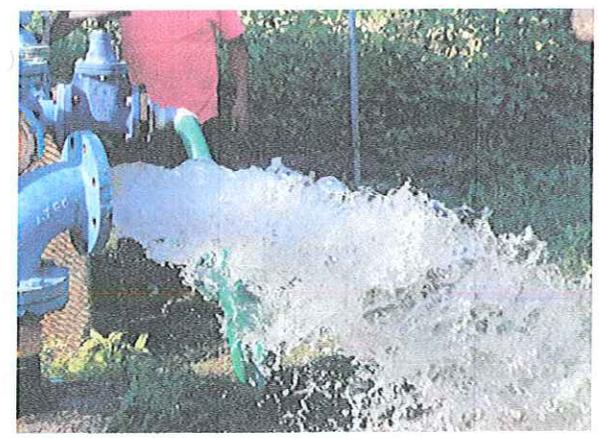
MONTAJE ELECTROMECANICO DE UNA BOMBA SUMERGIBLE 25 HP/220V- 84 MT DE COLUMNA ACERO AL CARBON 4", REPARADA PROPIEDAD DE CAPAMI, EN BOMBEO POZO PROFUNDO 1MYO COMONFORT, LOCALIZADO EN LA COL. 1 DE MAYO DE ESTA CD. IGUALA GRO.
