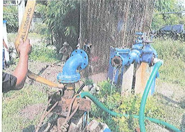
MONTAJE ELECTROMECANICO DE UNA BOMBA SUMERGIBLE 25 HP/220V- 84 MT DE COLUMNA ACERO AL CARBON 4", REPARADA PROPIEDAD DE CAPAMI, EN BOMBEO POZO PROFUNDO 1MYO COMONFORT, LOCALIZADO EN LA COL. 1 DE MAYO DE ESTA CD. IGUALA GRO.
