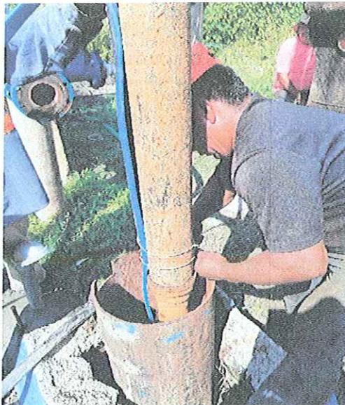
MONTAJE ELECTROMECANICO DE UNA BOMBA SUMERGIBLE 25 HP/220V- 84 MT DE COLUMNA ACERO AL CARBON 4", REPARADA PROPIEDAD DE CAPAMI, EN BOMBEO POZO PROFUNDO 1MYO COMONFORT, LOCALIZADO EN LA COL. 1 DE MAYO DE ESTA CD. IGUALA GRO.
