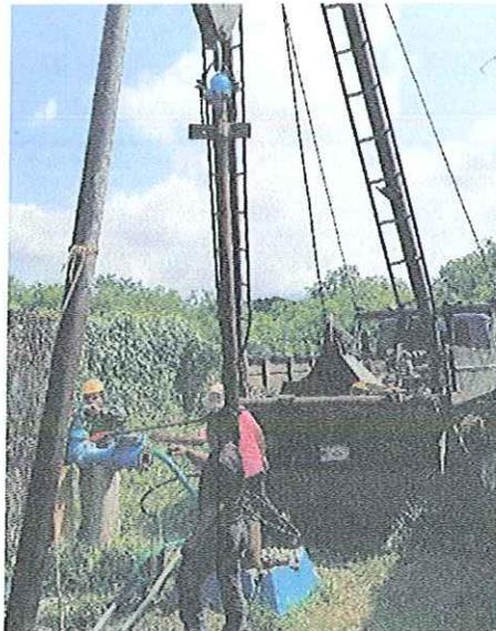
MONTAJE ELECTROMECANICO DE UNA BOMBA SUMERGIBLE 25 HP/220V- 84 MT DE COLUMNA ACERO AL CARBON 4", REPARADA PROPIEDAD DE CAPAMI, EN BOMBEO POZO PROFUNDO 1MYO COMONFORT, LOCALIZADO EN LA COL. 1 DE MAYO DE ESTA CD. IGUALA GRO.
