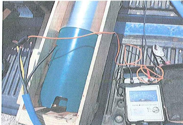
MONTAJE ELECTROMECANICO DE UNA BOMBA SUMERGIBLE 25 HP/220V- 84 MT DE COLUMNA ACERO AL CARBON 4", REPARADA PROPIEDAD DE CAPAMI, EN BOMBEO POZO PROFUNDO 1MYO COMONFORT, LOCALIZADO EN LA COL. 1 DE MAYO DE ESTA CD. IGUALA GRO.
