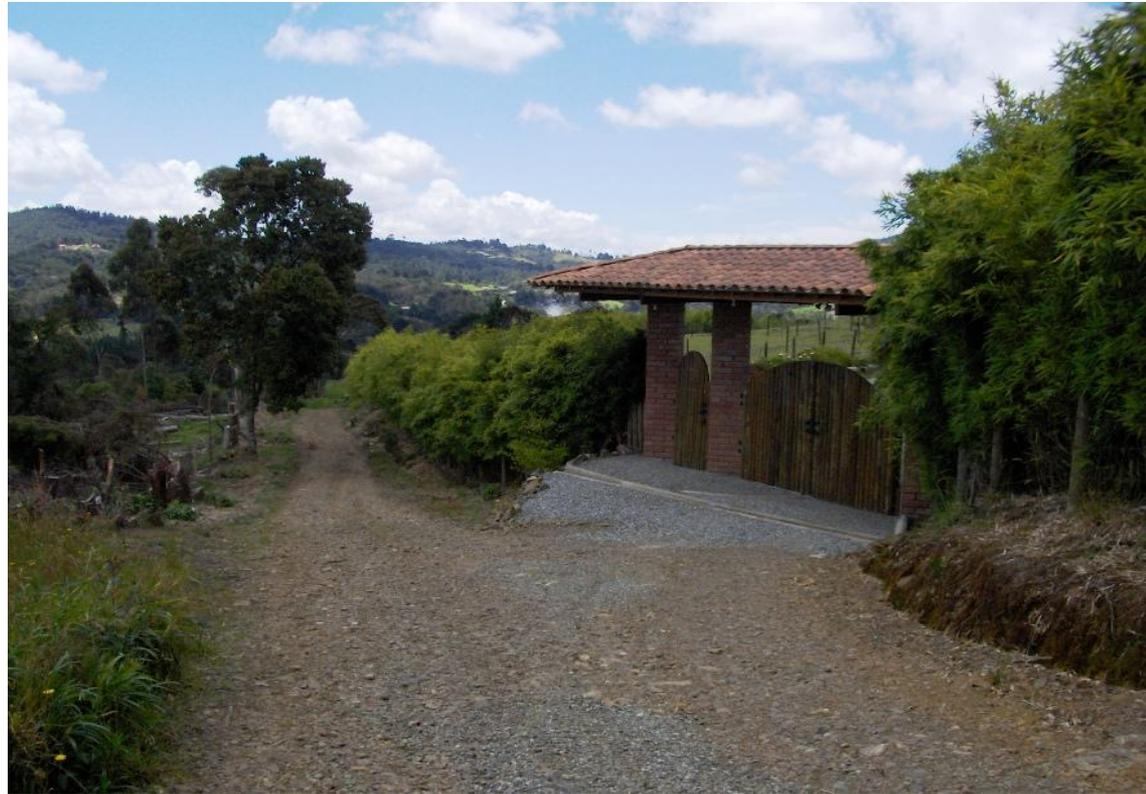
**Columnas del portón construidas en ferroconcreto y adobe macizo.
