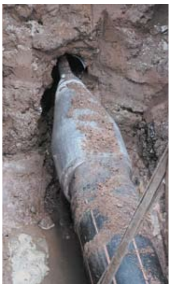
Introducción de tubería larga de cala a arqueta
