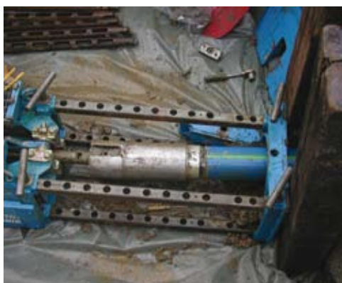
Renovación de una tubería AZ.
