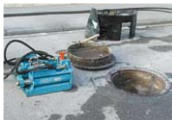
El GRUNDOBURST S esta preparado para su instalación en la arqueta de entrada
