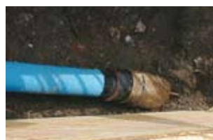
Introducción de una tubería de agua potable...
