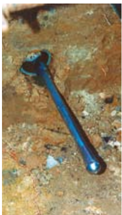
La barra guía en forma de pera a la llegada a la cala de salida.
