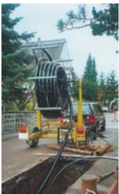
Tuberías de desagüe a presión
