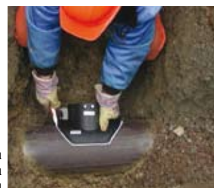
Colocación de la conexión para una acometida
