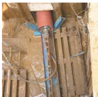
Introducción de tubería larga de cala a arqueta
