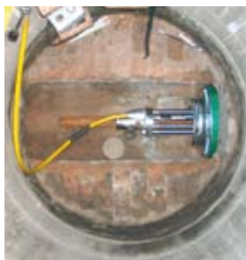
Con la ayuda de las barras Quick-Lock la vaina de dirección se empuja hasta la cala o arqueta de salida. (foto arriba izquierda). Allí se sustituye la vaina de dirección por el expansor y la tubería. Con ayuda del sistema de tensar Burstfix (foto izquierda) los tubos cortos son tensados entre si y sucesivamente introducidos.
