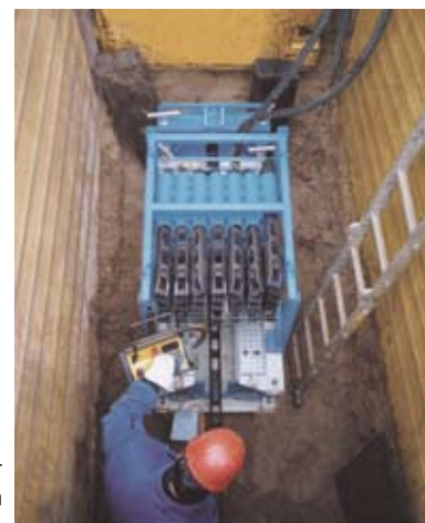
GRUNDOBURST en la introducción de las barras.
