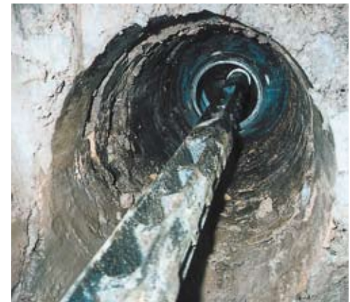
Las barras QuickLock en la tubería vieja durante el tiro.
