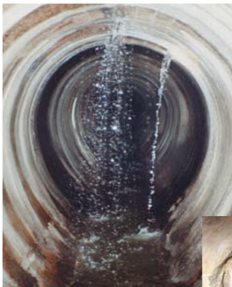
Infiltraciones de agua no contaminada. En 1 kilómetro de longitud se "perdieron" en un año casi un millón de metros cúbicos de agua. Esta cantidad corresponde al consumo anual de una pequeña ciudad de 20 - 30.000 habitantes.
