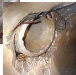
Infiltraciones de agua no contaminada. En 1 kilómetro de longitud se "perdieron" en un año casi un millón de metros cúbicos de agua. Esta cantidad corresponde al consumo anual de una pequeña ciudad de 20 - 30.000 habitantes.
