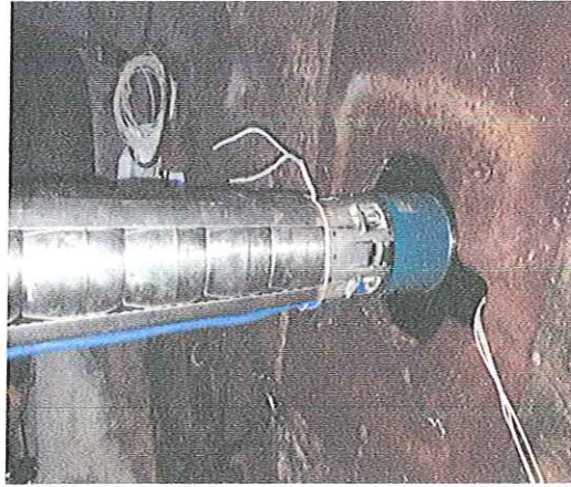
"SUMINISTRO, MONTAJE ELECTROMECANICO Y PRUEBAS DE UNA BOMBA SUMERGIBLE 30HP/220V-4 MT DE COLUMNA ACERO AL CARBON, EN REBOMBEO BUROCRATAS, LOCALIZADO EN CARR. IGUALA- CHILP., IGUALA GRO."
