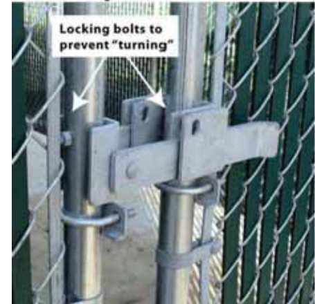
3 STRONG ARM GATE LATCH SCALE: N.T.S.
