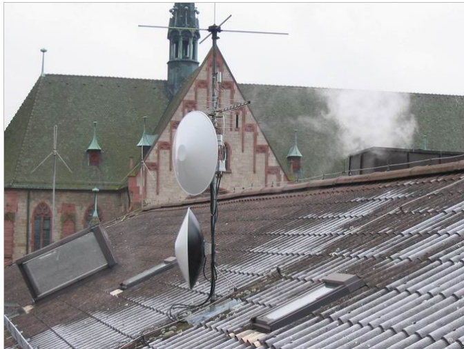
Für die WLAN-Übertragung kamen teilweise Antennen mit bis zu 80cm Durchmesser zum Einsatz.
