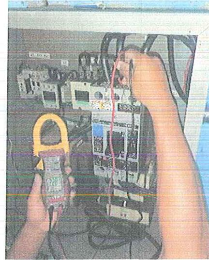
MANIOBRAS DE LIBRANZA EN ALTA TENSION, CANALIZACION EN TUBERIA NUEVA CONDUIT GALV 2 " DIA, SUMINISTRO Y MONTAJE DE INTERRUPTOR TERMOMAGNETICO EN CAJA MOLDEADA, 3X200 A/600 VCA
