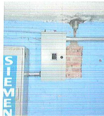
MANIOBRAS DE LIBRANZA EN ALTA TENSION, CANALIZACION EN TUBERIA NUEVA CONDUIT GALV 2" DIA, SUMINISTRO Y MONTAJE DE INTERRUPTOR TERMOMAGNETICO EN CAJA MOLDEADA, 3X200 A/600 VCA
