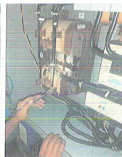
MANIOBRAS DE LIBRANZA EN ALTA TENSION, CANALIZACION EN TUBERIA NUEVA CONDUIT GALV 2 " DIA, SUMINISTRO Y MONTAJE DE INTERRUPTOR TERMOMAGNETICO EN CAJA MOLDEADA, 3X200 A/600 VCA
