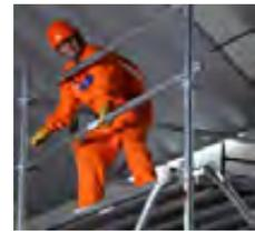
**Paso 9 ► Colocación del Rodapié:** Se debe colocar rodapié tanto longitudinales como laterales, insertándose la pestaña del rodapié entre el vertical y la cuña de la horizontal del mismo.
