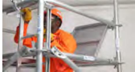
**Paso 8 ► Colocación Elementos de Seguridad:** Se deberá montar una doble baranda de protección; podrán ser largueros a 0.50 y a 1.00m con respecto a la plataforma de trabajo, esta se puede realizar mediante largueros estándar o tipo intermedio.
