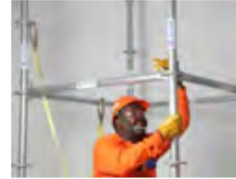
**Paso 6 ► Contra-Venteo del Módulo Base:** El elemento diagonal se deberá colocar siempre desde la roseta que esté situada a mayor altura del elemento vertical, con respecto a la situada en el nivel inferior del mismo, para ello se utilizarán los orificios en las rosetas, situados a 45° con respecto a los largueros. Las diagonales verticales siempre se dispondrán para el Contra-Venteo vertical. Las diagonales horizontales van a nivel horizontal.
