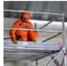
**Paso 10 ► Continuación del armado de la torre:** La secuencia de armado se repetirá del paso 5 al 9 hasta finalizar la torre, revisando el plomo en cada nivel.
