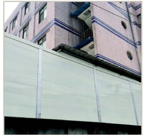
隔音牆安裝於女兒牆
